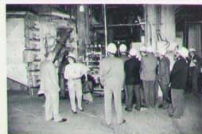
Presentazione dimostrativa delle apparecchiature DIACO installate nelle caldaie e nei condotti fumi della centrale di Marghera.
